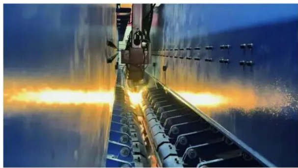
图 3-5 浙江三澳核电应用智能激光跟踪自动焊技术
