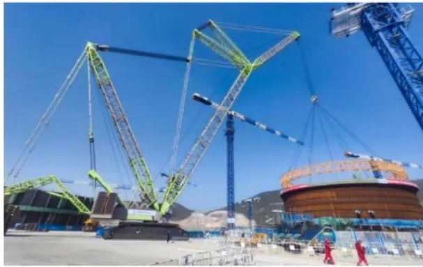
图 3-4 浙江金七门核电钢衬里模块化吊装
