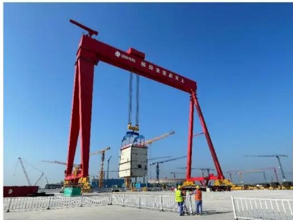
图 3-6 广东廉江核电应用龙门吊安装大型结构模块
