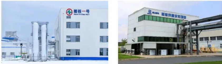
图 2-5 山东海阳、浙江秦山核电供暖项目
